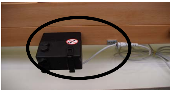
Fig. 4: Strekkavlaster og styreboks festet på montasjeplaten
