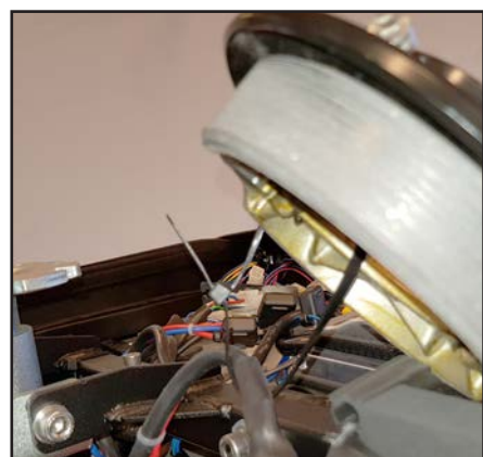
Bruk ev. et langt kabelstrips for å holde den, under arbeid.
