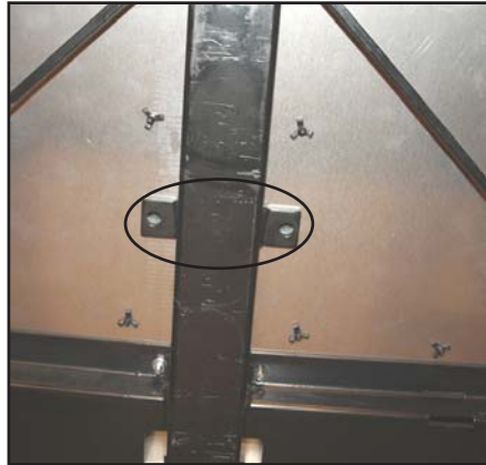
Bor to hull opp gjennom bunnplaten med de viste hullene som mal.
