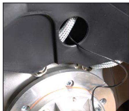
Følerens ledning føres igennem hullet og op til El-pladen.
